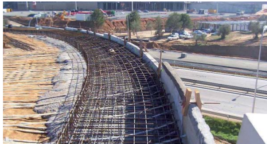
Borde de muro sin proteger. Esta situación se evitará en todo momento. Si fuese imposible el disponer de una protección colectiva efectiva, será obligatorio el uso de dispositivos de seguridad anticaídas.
