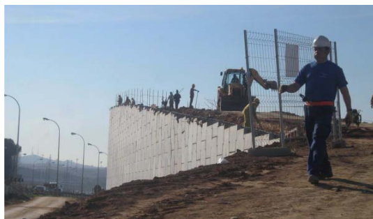
Un vallado como el mostrado en la fotografía puede ser una buena solución frente al problema de las caídas en altura.
