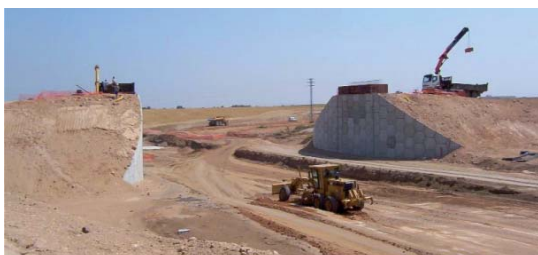
Ejecución de paso elevado. El riesgo de caída de altura es evidente. Se protegerán frente a caídas, todos los desniveles, tanto en los estribos como en los muros y bordes de terraplenes.
